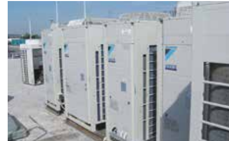
Các dàn nóng VRV III-Q sử dụng R410A đảm bảo tuân thủ theo các tiêu chuẩn mới nhất.
