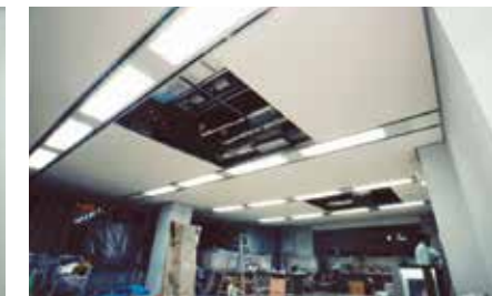
2 Công việc thực hiện trong thời gian ban đêm
