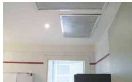
Công việc lắp đặt đã được thực hiện vào cuối tuần để giảm thiểu sự gián đoạn trong kinh doanh.
