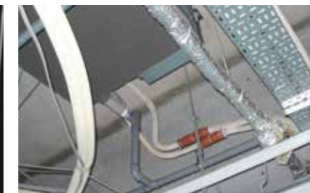
8 Đường ống dẫn môi chất
