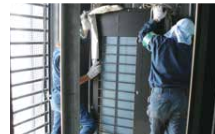
7 Lắp đặt dàn nóng
