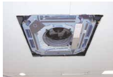
Lắp đặt dàn lạnh mới
