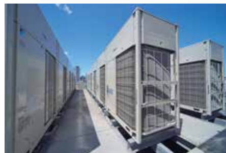
Lắp đặt VRV Q
