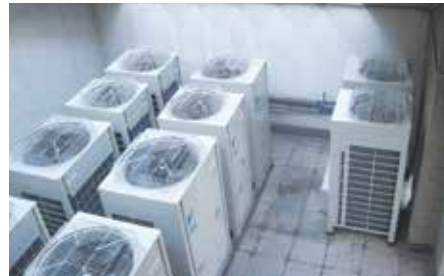
Các dàn nóng VRV cũ sử dụng R22 được thay thế bằng các dàn nóng VRV III-Q sử dụng R410A.
