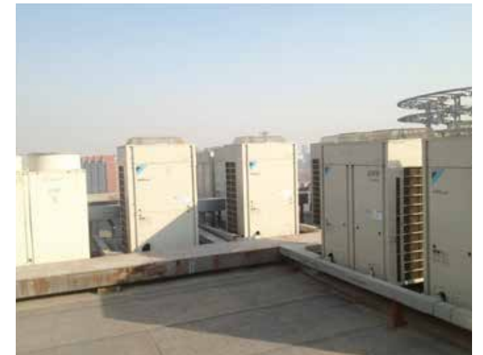
Sau khi thay thế Lắp đặt VRV Q
